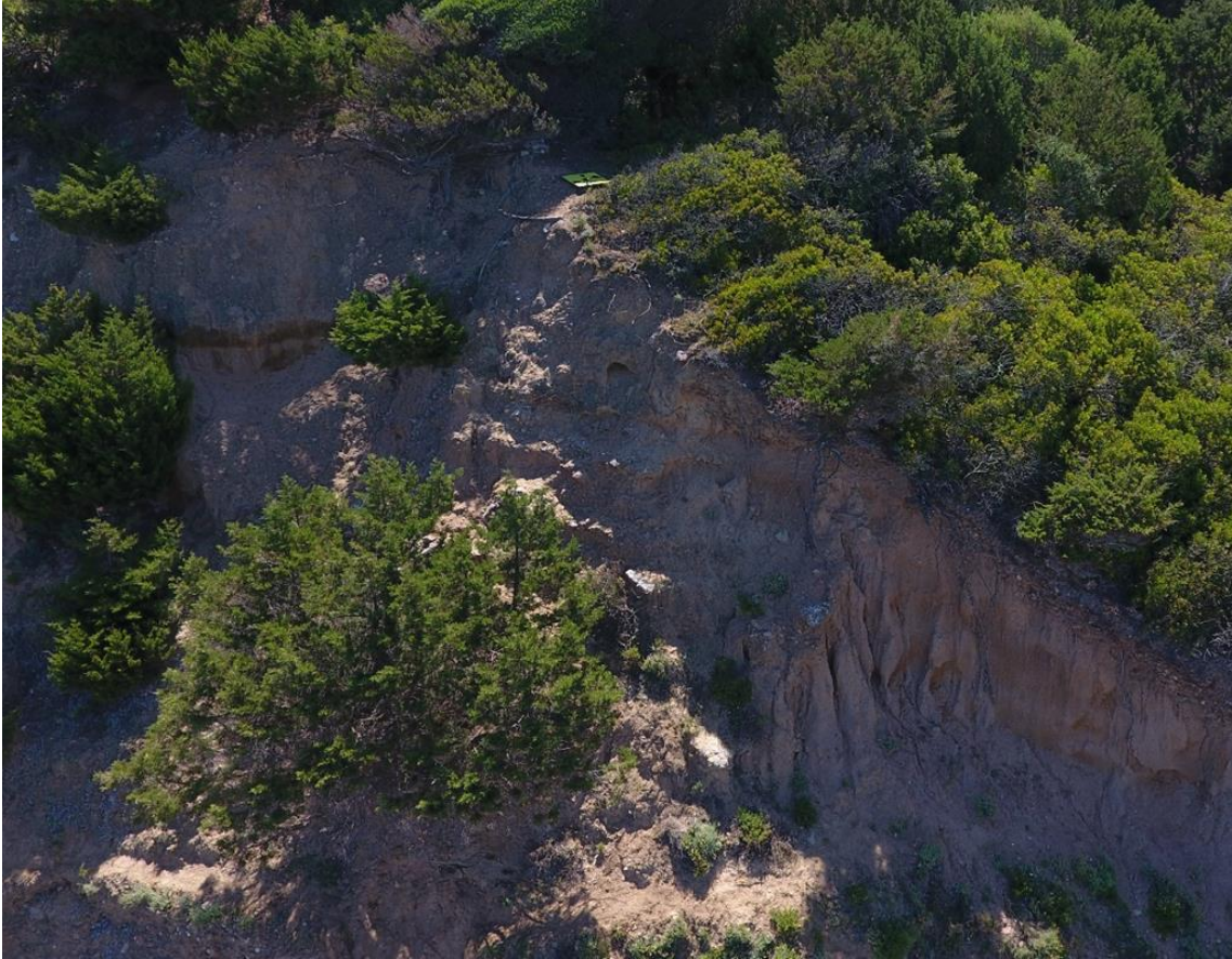
Figura 20: Settore superiore del versante interessato da processi di erosione areale nelle aree prive di vegetazione arborea e arbustiva (1) ed erosione concentrata (2).
