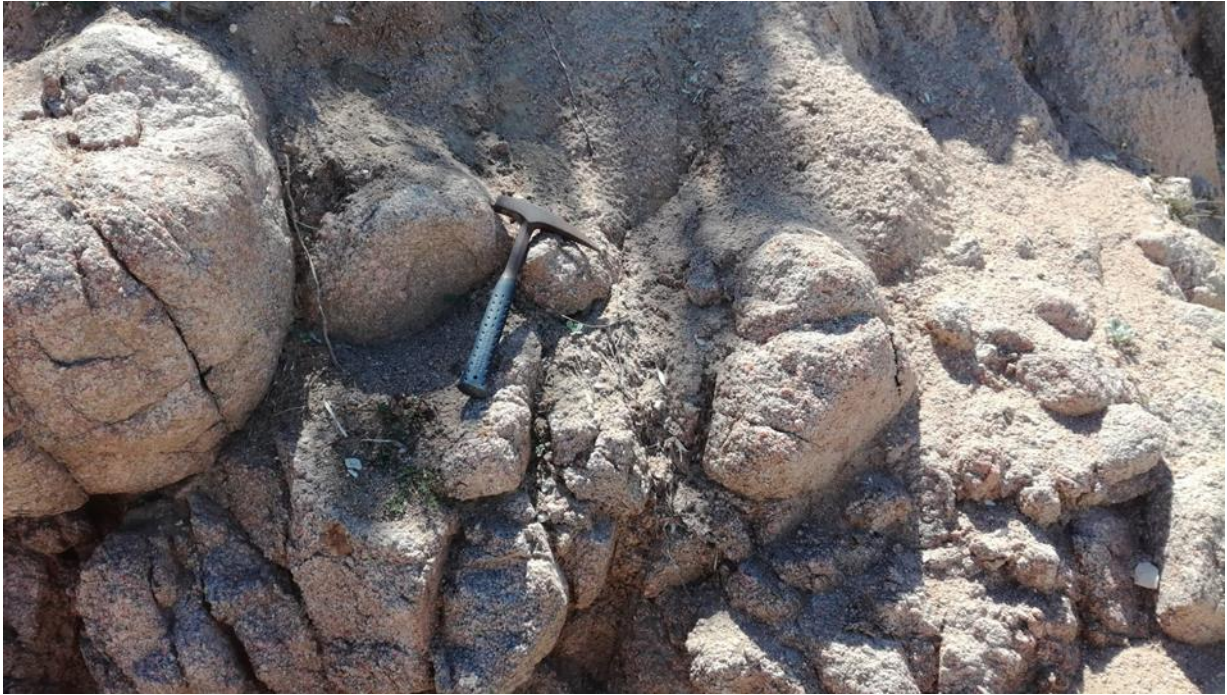
Figura 19: Affioramento di granito alterato alla base della ripa di erosione.
