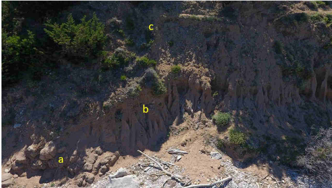
a) substrato monzogranitico alterato. b) Erosione lineare (Rills). c) area interessata da erosione diffusa
